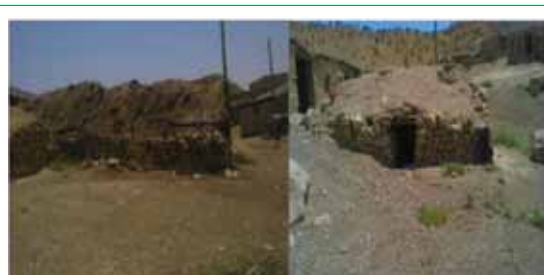
شکل ۱۴: دو نمونه از طویله در شهرستان کوه‌دشت که با استفاده از مصالح بومی سنگ، گل و حصیر ساخته شده است
